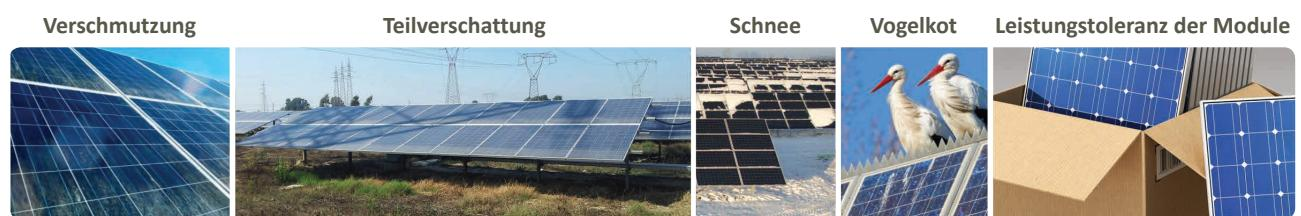
Bei traditionellen Wechselrichtern reduziert das schwächste Modul die Leistung aller anderen Module im Strang.
